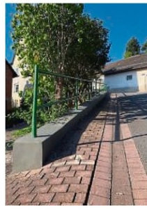
Wieder stabil: die Mauer in Neuerode. FOTO: PRIVATIMH
