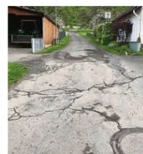
Verschwunden: die tiefen Risse und Schlaglöcher im Schmiedeköpfchenweg wurden repariert. FOTO: PRIVATIMH
