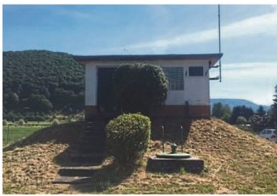
Ab hier im freien Fall: Vom Flachbrunnen Frieda werden Grebendorf und die Hessische Schweiz versorgt.
