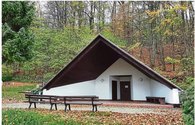
Die Trauerhalle in Hitzelrode soll verglast werden. Das soll der Trauergemeinde Schutz vor Witterung bieten. Baustart ist für nächstes Jahr vorgesehen.
