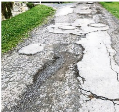
Hatte es dringend nötig: Der Belag des Schmiedeköpfchenweges in Motzenrode wurde erneuert.
