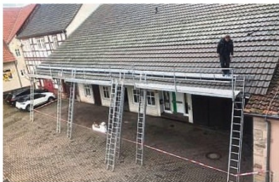
Die Montage der Photovoltaik-Anlage auf dem Nordflügel der Gemeindeverwaltung in Grebendorf. FOTO: PRIVAT
