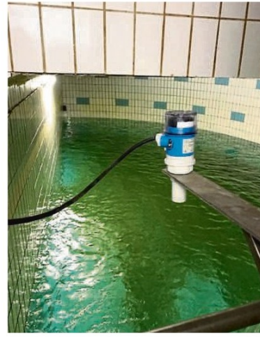
Eine der Baustellen der Gemeinde Meinhard: die Wasserversorgung.
