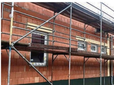
Ist jetzt winterfest: Friedas Feuerwehrleute haben in kürzester Zeit 24 Fenster in den Rohbau eingesetzt.
