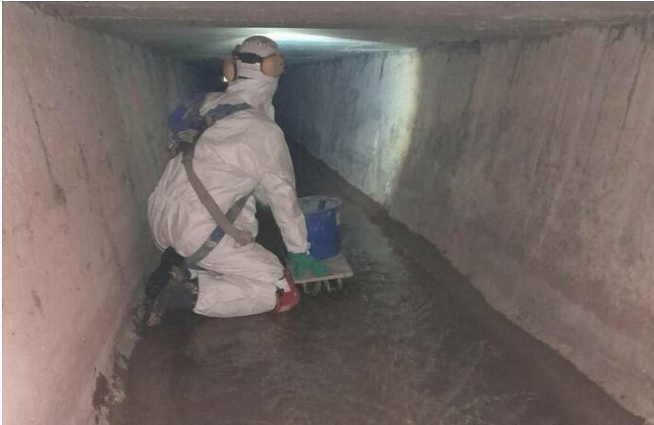
Auf Knien muss bei der Reparatur der Unterbewehrung des Mühlbachs in Jestädt gearbeitet werden. Der Stahl liegt zum Teil frei. Foto: Privat
