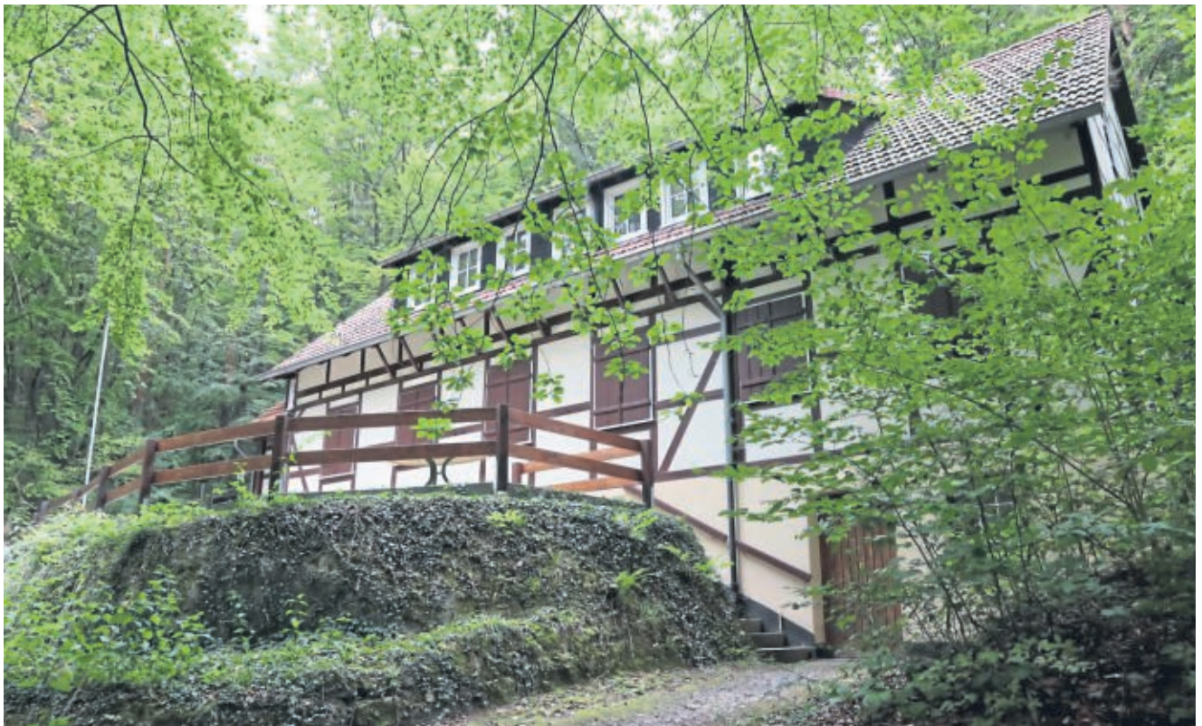
Weder Waldkindergarten noch Wanderheim: Die Bauaufsicht des Landkreises hat das Wanderheim Siechenborn wegen fehlenden Brandschutzes gesperrt.
