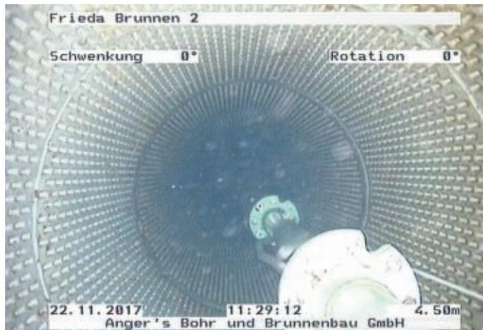
Ein Blick in die Röhre: Die Aufnahme zeigt die 60 Zentimeter Durchmesser umfassende Röhre des Flachbrunnens Frieda.
